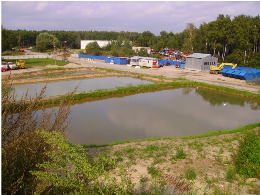
Рисунок 34 - Пилотная установка по сбору и очистке фильтрационных вод на полигоне опасных отходов г. Калининграда
