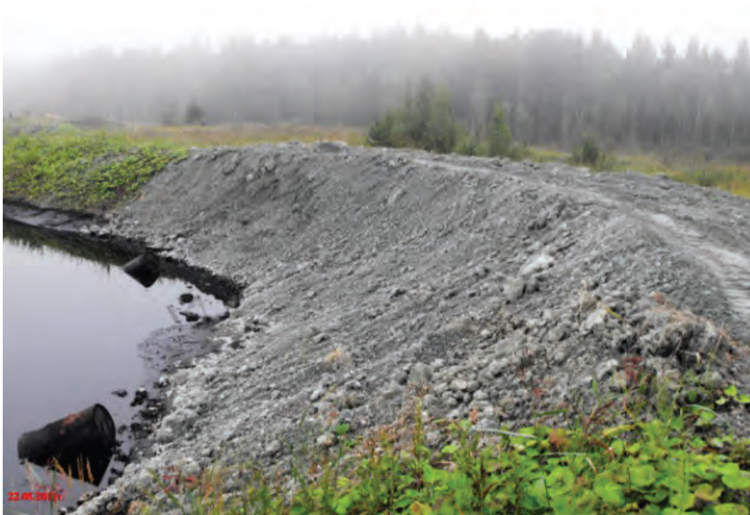
Рисунок 6 - Результаты ремонта дамбы обвалования карты-котлована № 68
