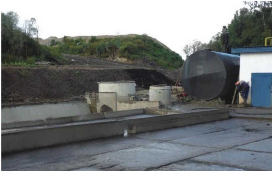
Рисунок 33 - Приемные колодцы на полигоне опасных отходов г. Калининграда
